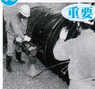
11 管側部転圧（振動ローラー）
